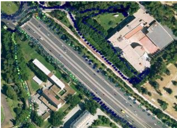
Imagen 4.15. ETSI Navales y Av. Arco de la Victoria
