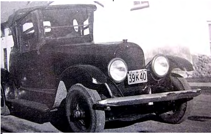
Foto 5.11. Galt Gas Electric.
