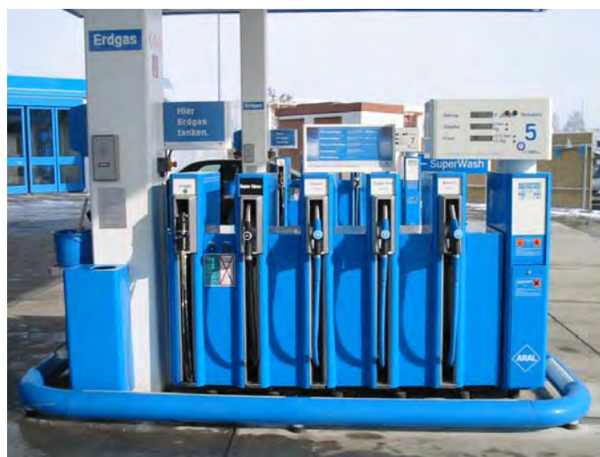
Foto 6.13. Estación de servicio de GNC y vistas de un surtidor.
