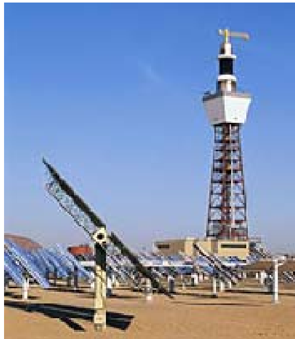
Figura 2.2.8.5 Torre solar y helióstatos
