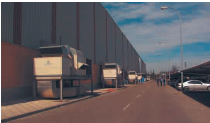
Foto 4.3. Zonas de renovación y climatización de naves en un gran centro logístico de la Comunidad de Madrid. Fuente: Geoter.
