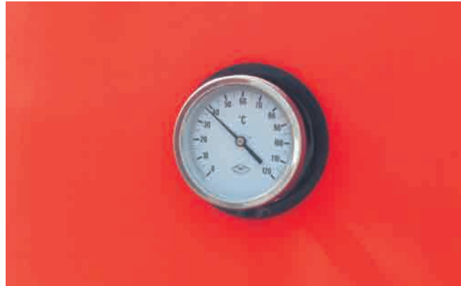
Foto A1 2. Temperatura de detalle en depósito de inercia en centro logístico de la Comunidad de Madrid. Fuente: Geoter.
