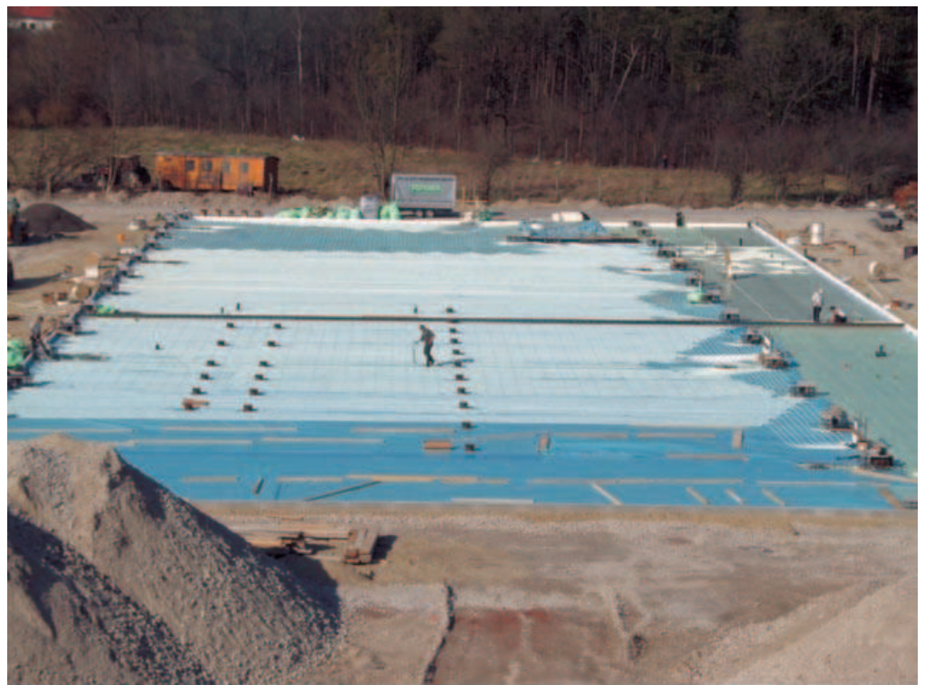
Foto 1. Suelo radiante en construcción (Foto: Citrin Solar).
