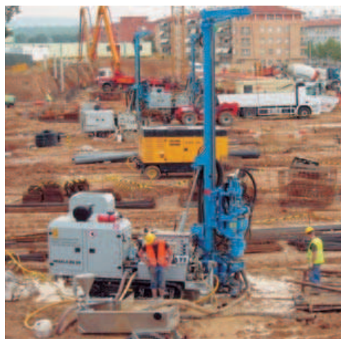
Foto 2. Perforación de los sondeos geotérmicos (izquierda) e introducción de la sonda (U-tube) en la perforación (derecha).
