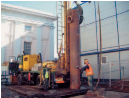
Foto 1. Realización de un pozo para el sistema de ASET-A para la ampliación (New South West Wing) del National Maritime Museum en Londres (Fuente: IFTech Ltd.)
