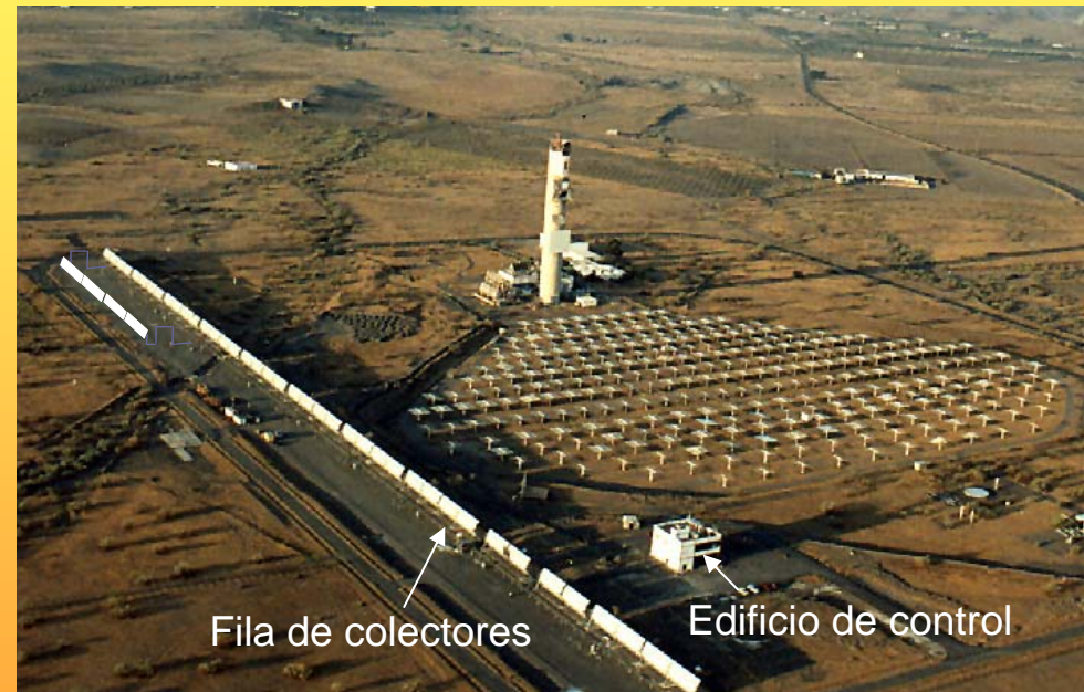
Vista aérea de la planta
